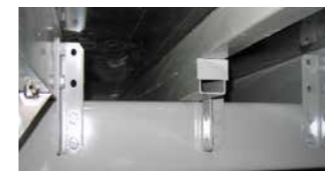
縦根太高さ変更、横根太増し
